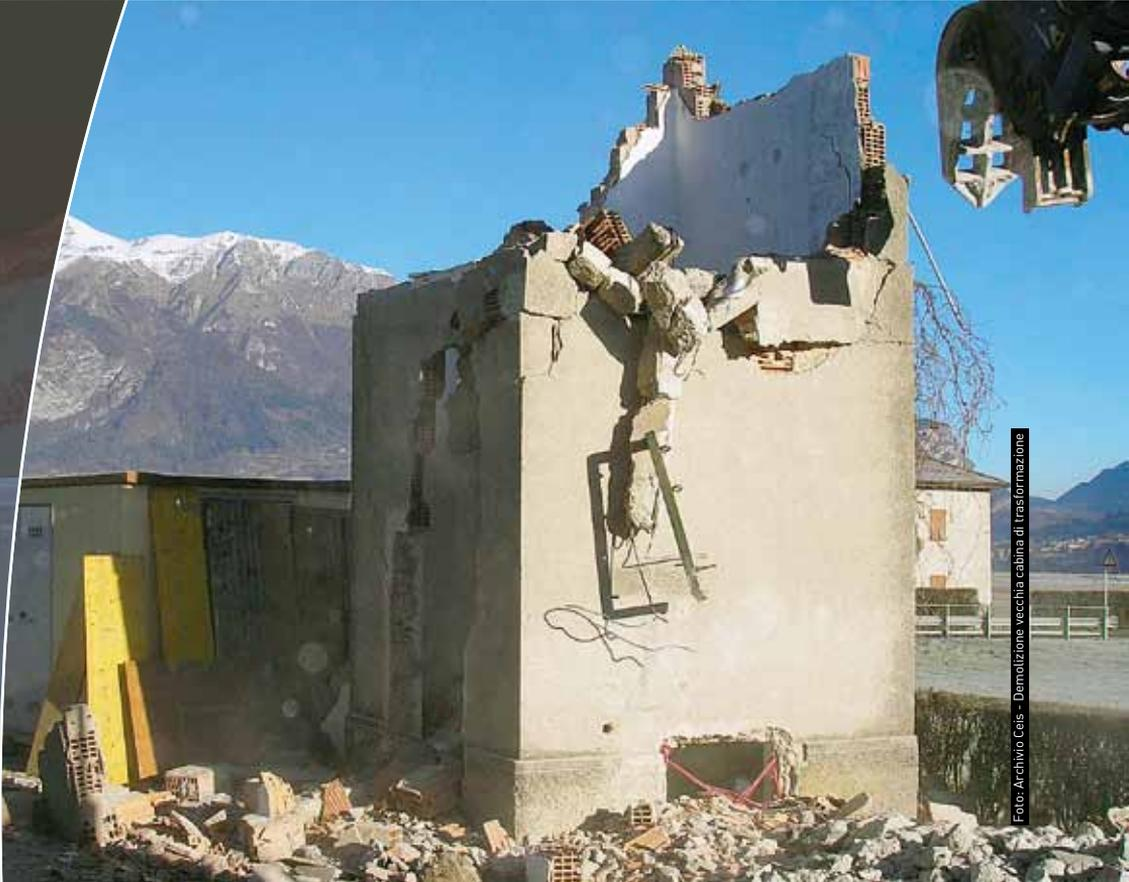
Foto: Archivio Ceis - Demolizione vecchia cabina di trasformazione
